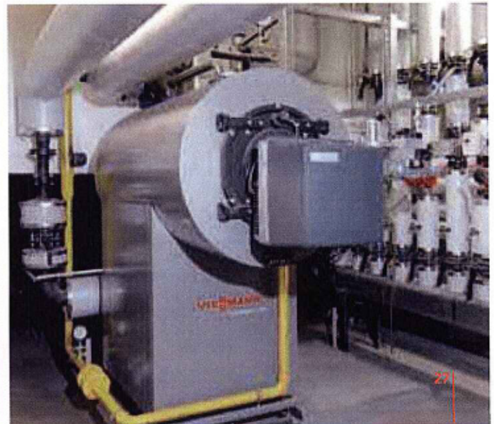
Ein KÖB-Pyrot-Heizkessel und ein Gas-Brennwertkessel Vitocrossal 300 sorgen für Wärme in dem ehemaligen katholischen Exerzitenheim.
